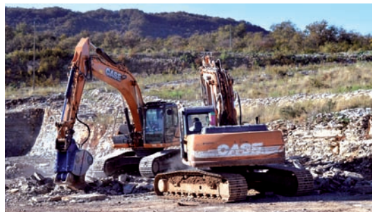
L'arrachage mécanique des dalles du gisement
